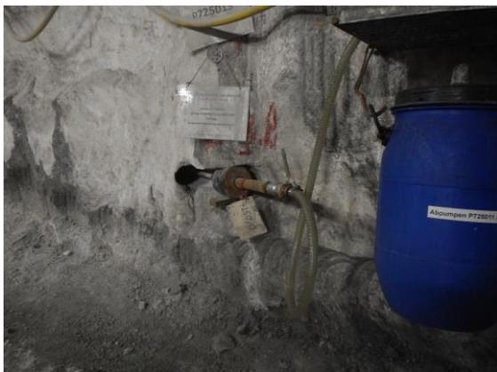
Bild 9: Fallende Erkundungsbohrung EBrG. 08/725 (in SE-Richtung, ABR3) im Pfeiler 2-3/725 auf der 725-m-Sohle, P725019.
